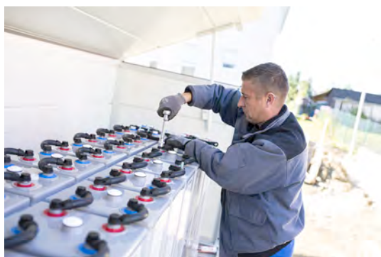
Blei-Gel-Speicher optimiert den Eigenverbrauch Quelle: BSW-Solar/Borrmann
